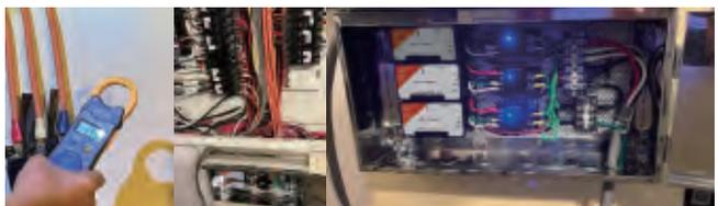
安裝原因:線路過度老舊，漏電三項不平衡造成跳電無法解決。
