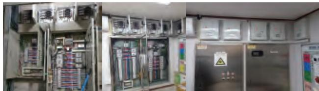
安裝原因:電力設備漏電，漏電量分別為2250mA、1920mA、160mA。
