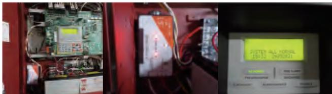
安裝原因:不明原因設備偵測到洩漏電流，造成設備無法正常運作。
