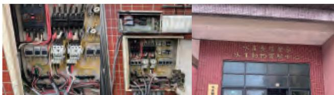
安裝原因:養殖魚塭馬達漏電，造成無法送電。
